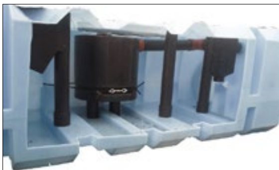
Pumpbrunnen Pump-in-Tank monterad och klar i slama­vskiljaren. Nästa steg är att montera stös och pump.
