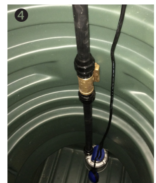
4 Pumpinredning monterad i kombibrunnen som nu blivit en pumpbrunn inklusive pump.
