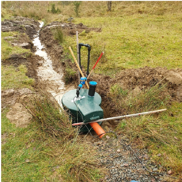
Figur 4. Djuvarp 1:21, 25 oktober 2022. Pumpbrunnen monterades där utloppet mynnade i befintligt dike.
