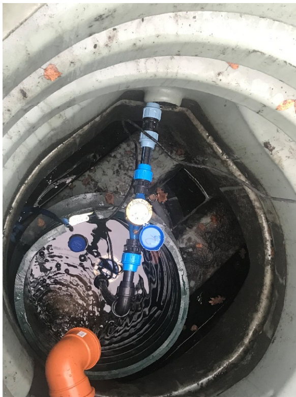
Figur 5. Dal 1:3, 7 november 2022. Pumpbrunnen vid utloppet monterades i befintlig fosforfälla.
