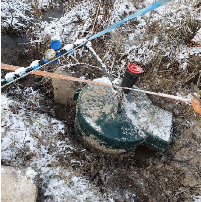
Figur 6. Hemshyttan 8:4, 5 december 2022. Pumpbrunnen monterades där utloppet mynnade i befintligt dike.
